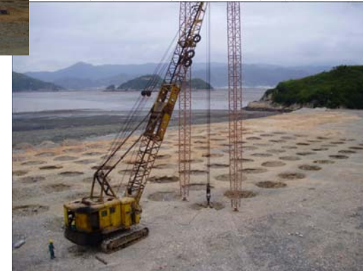
小区域单台强夯设备强夯作业过程
